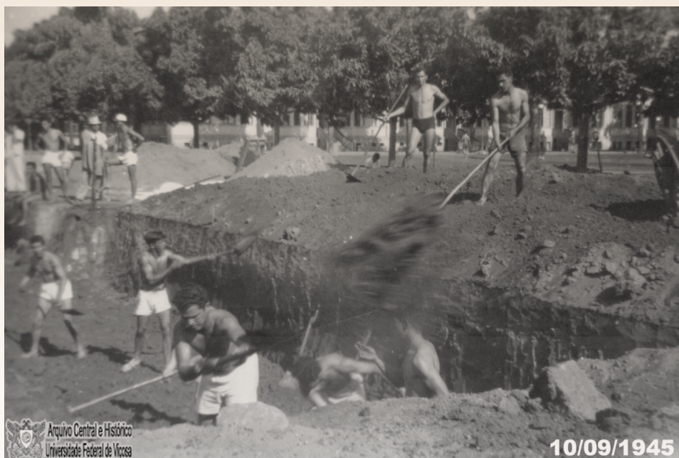
Construção da piscina do Diretório Acadêmico da ESAV (atual Piscina do DCE), iniciada pelos operários em 1945. O início da obra contou com ajuda expressiva dos alunos da ESAV (presentes nas imagens) durante a abertura do buraco. A identificação dessa fotografia teve a colaboração do Professor Flávio Augusto D'Araújo Couto. https://locus.ufv.br//handle/123456789/10385
